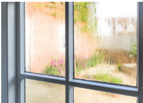
冷凝首先在房間最冷的表面形成，通常是在門窗的玻璃表面。
