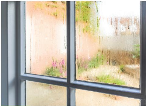
冷凝首先在房间最冷的表面形成，通常是在门窗的玻璃表面。
